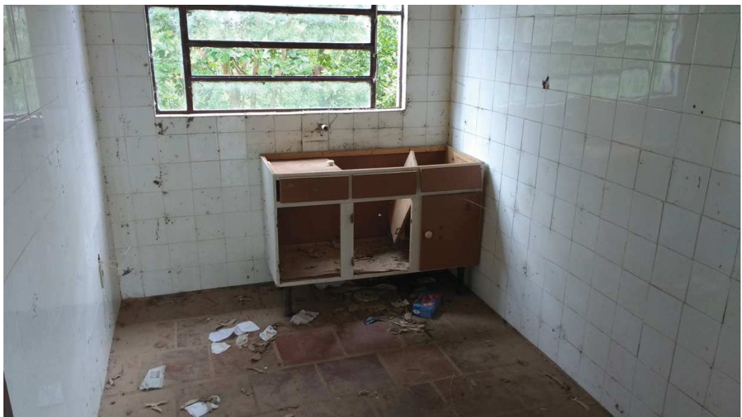
Cozinha/Depósito (foto tirada em 18/12/2017).
