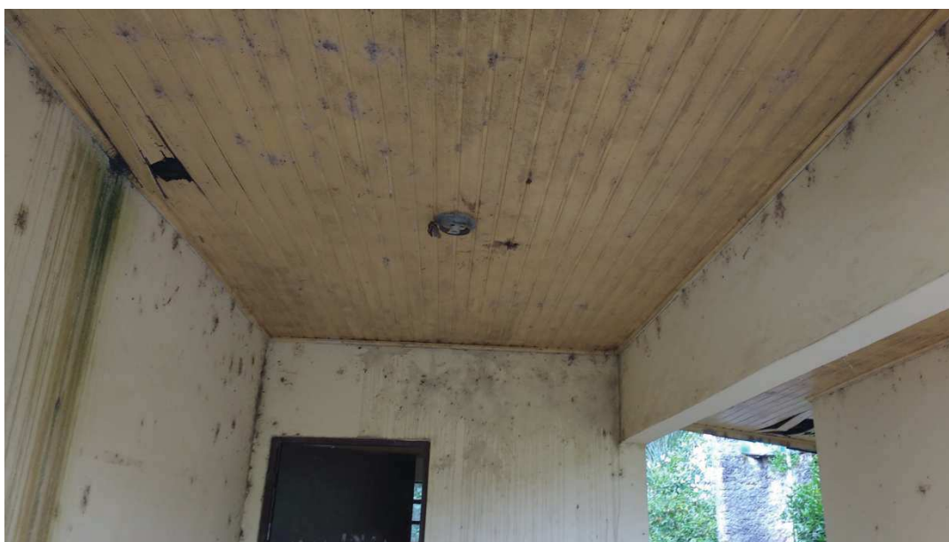
Fôrro Área (foto tirada em 18/12/2017).
